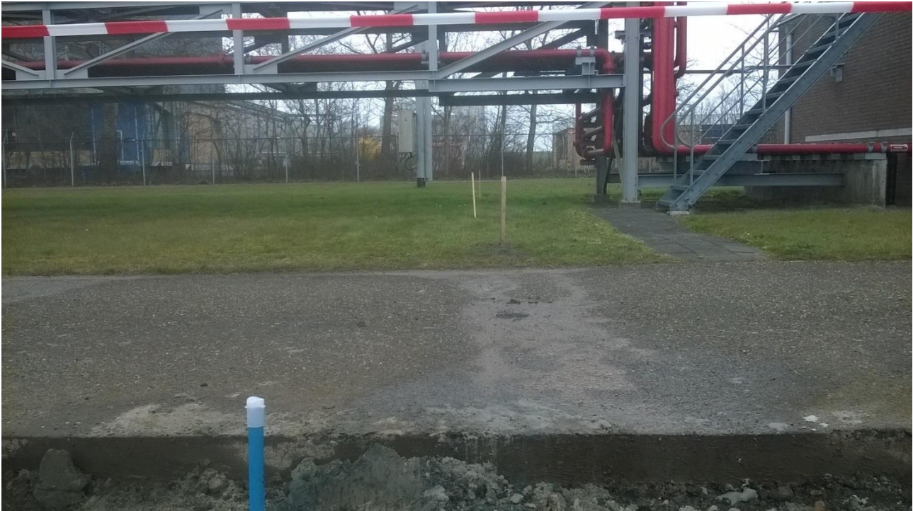
Figuur 1: Pijpenbrug (de verontreiniging loopt vanaf de blauwe peilbuis op de voorgrond door tot onder de pijpenbrug)
