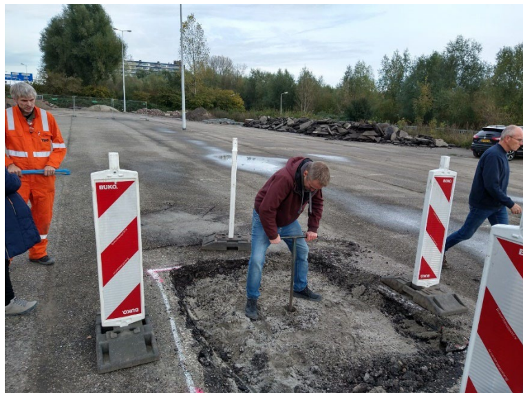
Figuur 46: Boorgat zetten voor boxmeting
