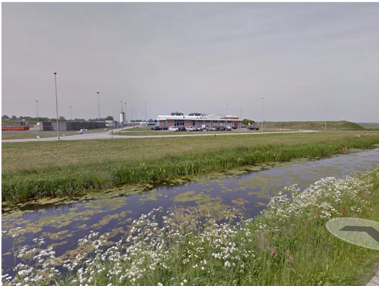
Figuur 4.4: Bestaande situatie locatie WHC-2
