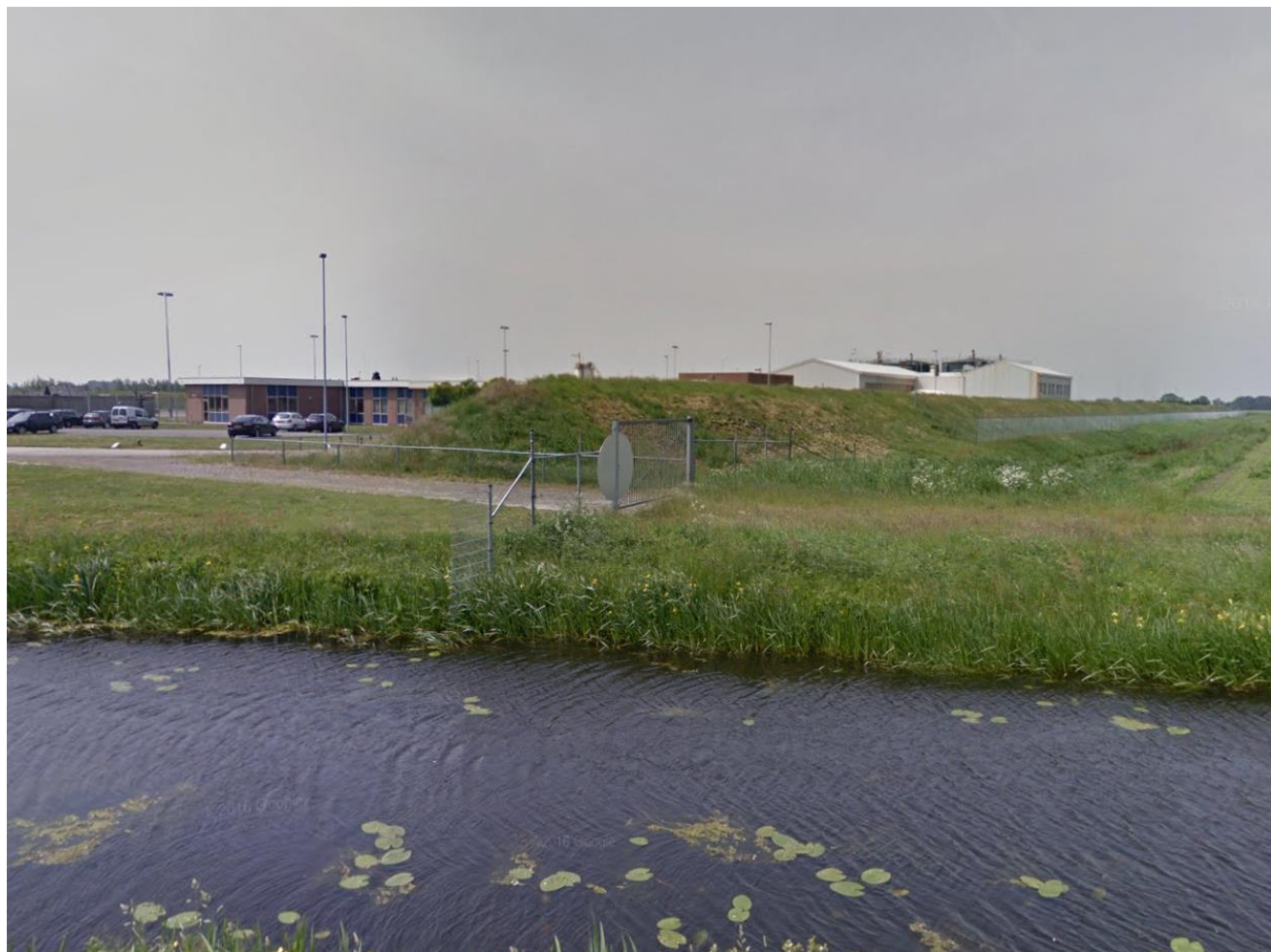
Figuur 4.3: Bestaande situatie locatie WHC-2
